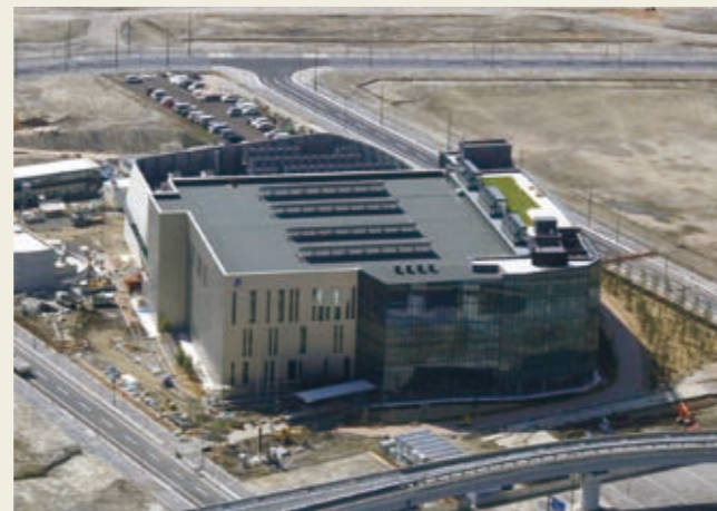
建設が進む次世代スーパーコンピュータ施設
