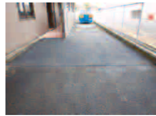
(C棟改修後全景)
