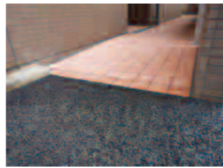
(C棟改修後)
