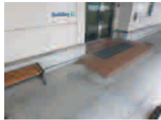
(B棟改修前)
