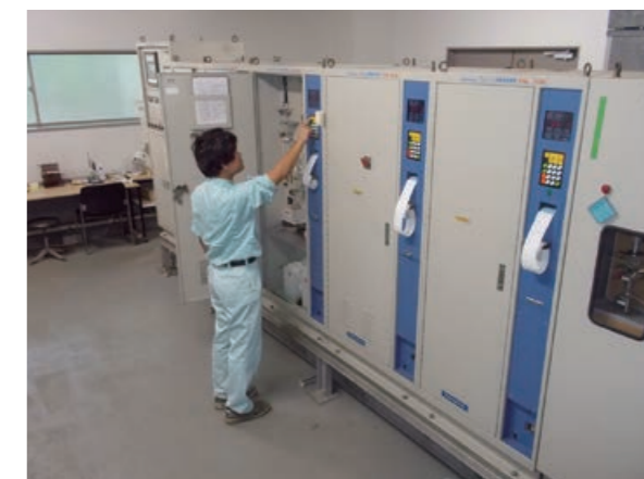
水質自動監視装置
