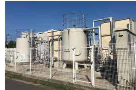
地下水給水装置の設置
