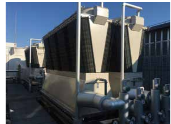
空冷式チラーユニットの更新
