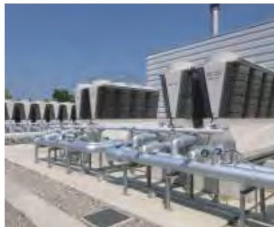
動力棟熱源機器更新
