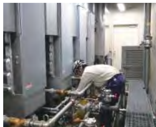
蒸気ボイラーの定期点検の様子
