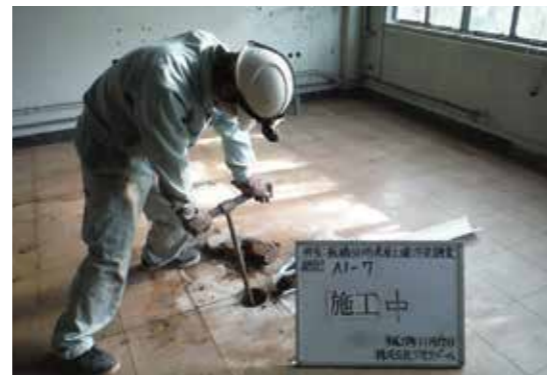
土壌汚染調査のための土壌採取
