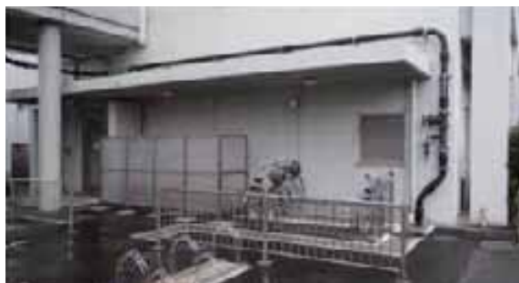
地中埋設配管を地上配管に仕様変更(西研究棟)
