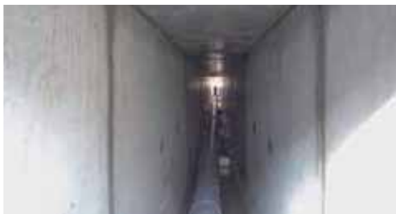
トレンチ内配管
