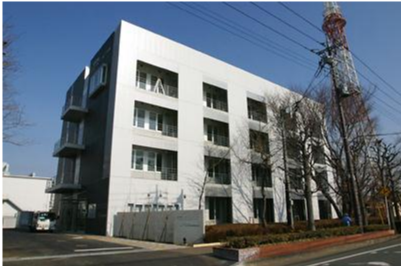
和光理研インキュベーションプラザ外観
