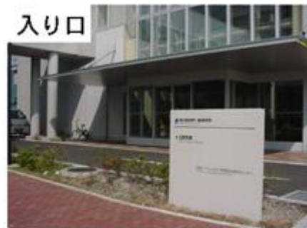
図 4. 免疫・アレルギー科学総合研究センターの研究棟
