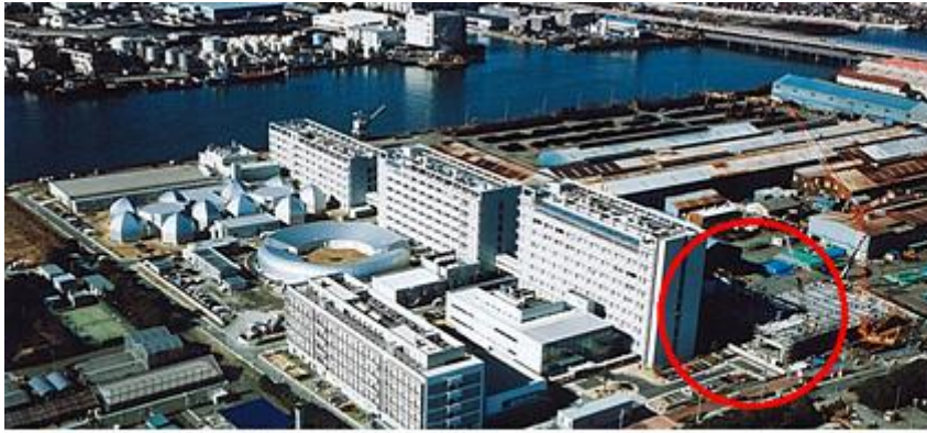
建築中の写真（2003年4月）
