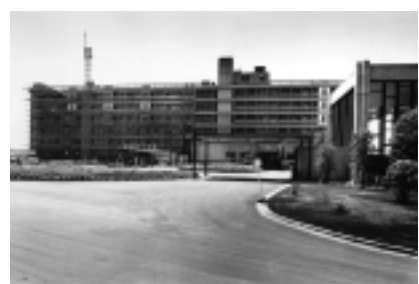
完成した本館研究棟第3期
