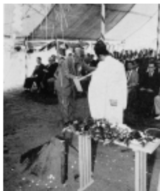
長岡の手で鋤入れ（地鎮祭）
