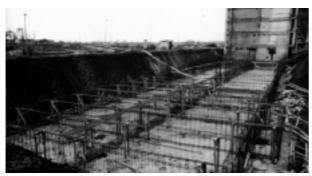
本館研究棟(第2期)の建設現場 (基礎梁配筋工事企と地下第1階床面工事®)
