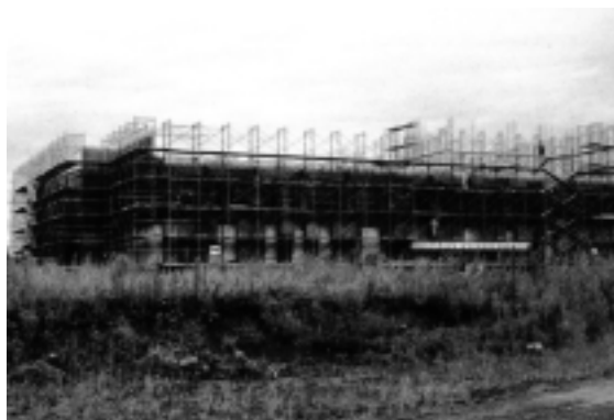
遺伝子組換え実験用としては最初のP4レベル実験室を持つ遺伝子組換え実験棟の建設
