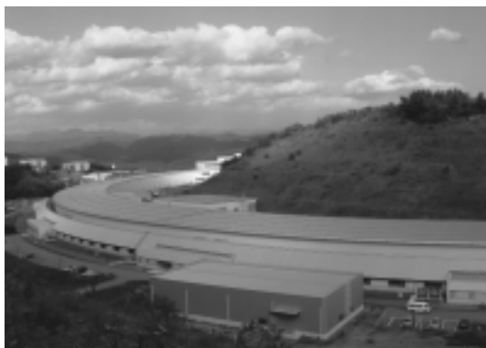
切り崩す予定の三原栗山を温存し、 山の周囲に建設した蓄積リング
