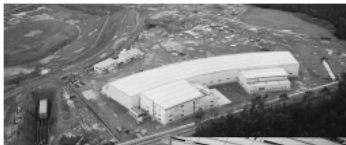
蓄積リング棟第1期工事竣工(1992年12月)
