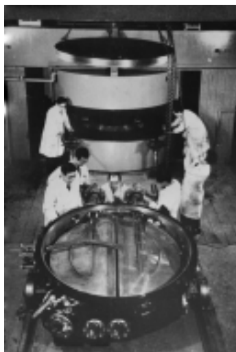
仁科が自ら指揮し、組み立てた大サイクロトロン（1938年に組み立て据付を完了するが、高周波発生器の真空に問題が・・・）
