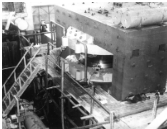
全重量350トンの主電磁石据付けが完了（磁場測定を終えて総合組立てへ）
