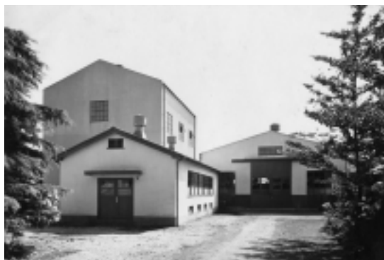
加速器研究棟群（右奥が、電源室やサイクロトロンの研究室の35号館、左奥が、コッククロフト加速器の研究室の37号館、手前は、蓄電池室の39号館）
