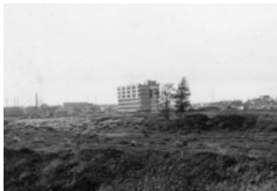
サイクロトロンの建設現場から眺めた理研の敷地（わずかに、本館研究棟（第1期、2,000坪）が建っただけであった）
