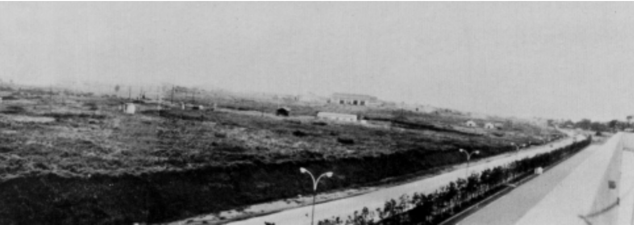
昭和38年8月、着工直後に北側から見た敷地全域
