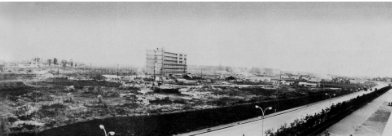
昭和39年12月ごろの建設状況 中央右寄りの地上6階、地下1階の建物が本館研究棟 敷地左端の建物がサイクロトン本棟
