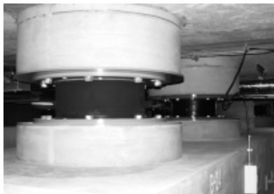
免震工事を終えた研究本館地下
