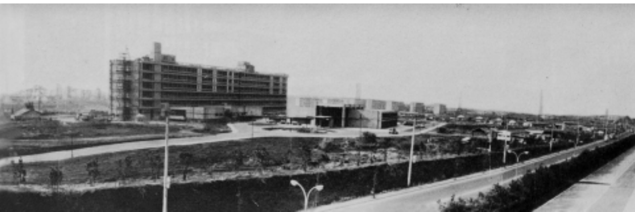
昭和41年11月、第1期計画の主要建物が完成したころ
