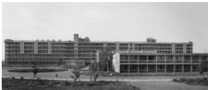
完成した本館研究棟（後方）と事務棟（手前）
