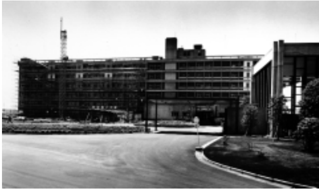
完成間近の本館研究棟（第3期工事）
