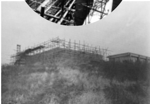
完成近いサイクロトロン本棟とその建築現場（丸写真）
