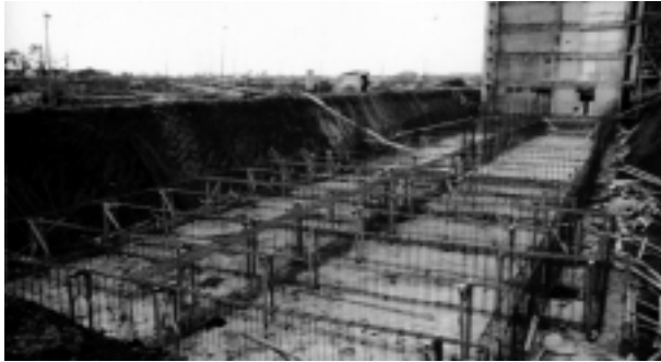
本館研究棟(第2期)の建設現場 (基礎梁配筋工事④と地下第1階床面工事⑤)
