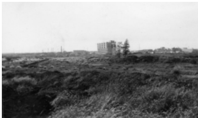
サイクロトロン建設現場から見た建設中の本館研究棟
