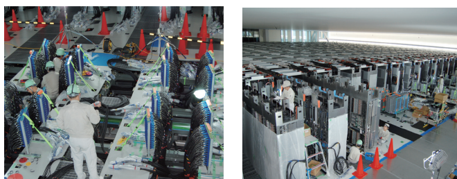
図3 計算機の設置、ケーブル接続の作業風景
