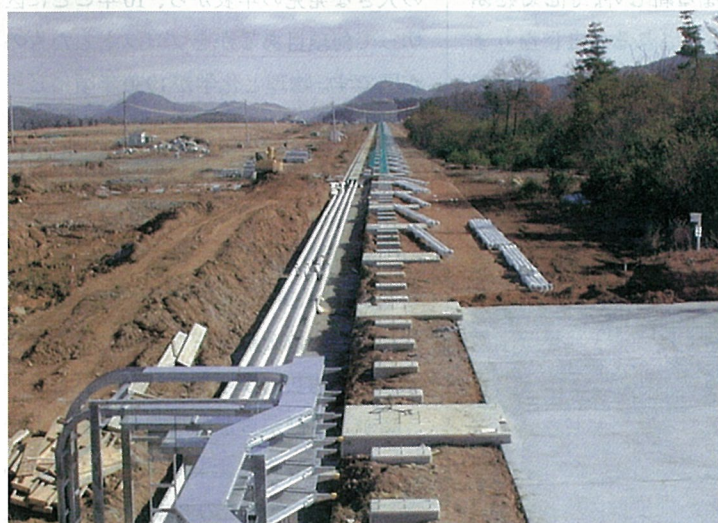
SPring-8に建設中の1 kmビームライン (I)。外周道路高架部から下流側を望む。
