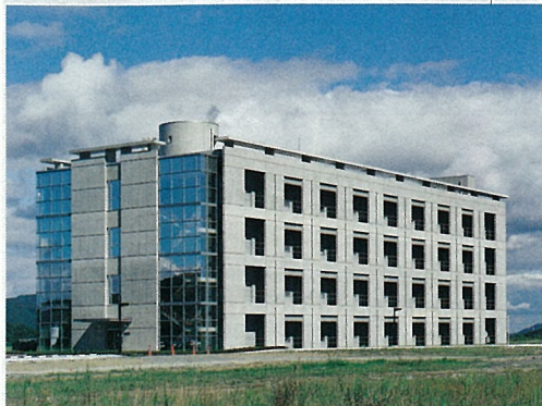
中心施設となる構造生物学研究棟
