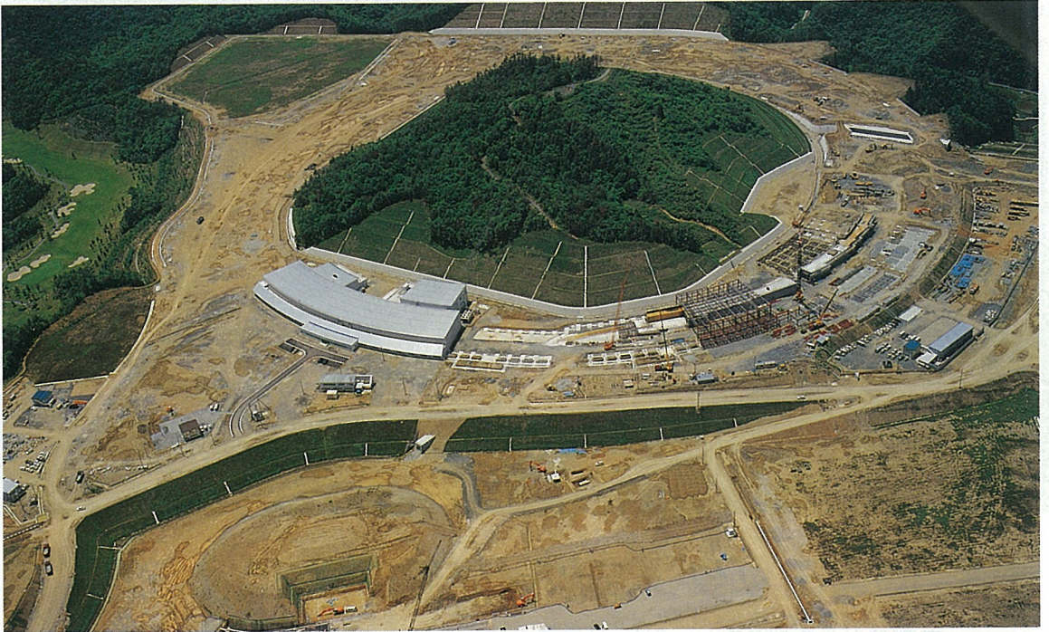
図-1 現地航空写真、白く光る建物が第1期(1/10)完成の蓄積リング棟
