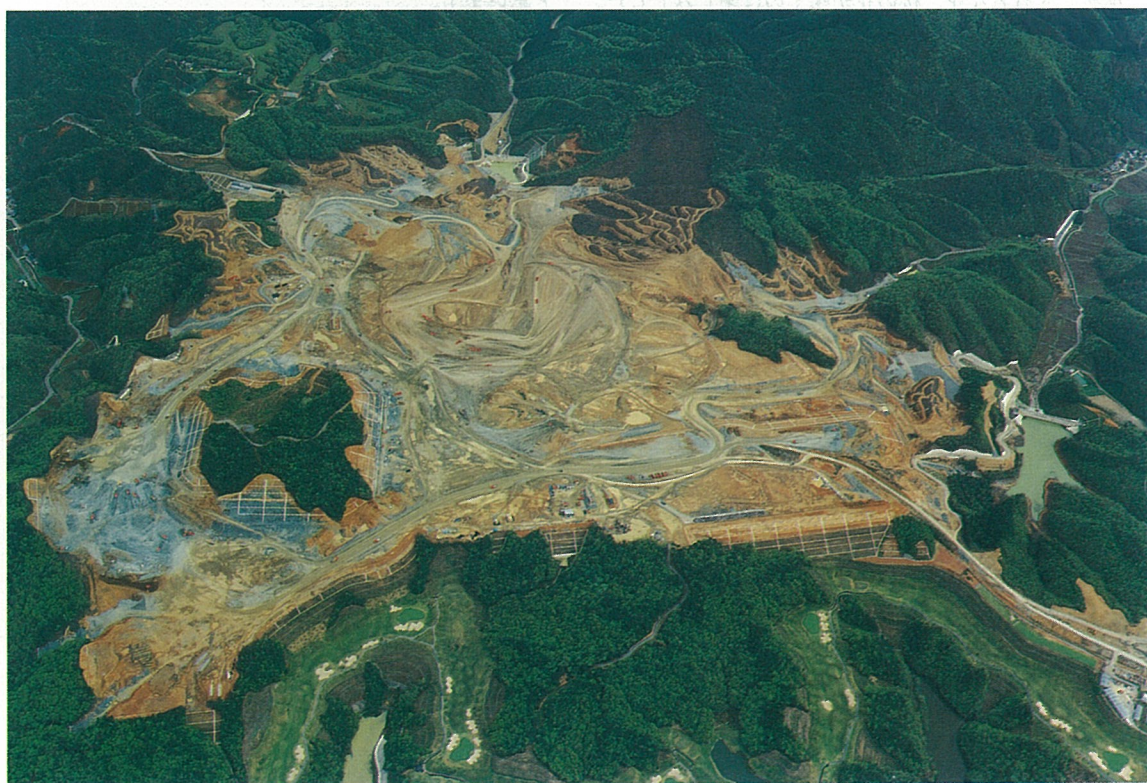
図7. 現地造成写真
