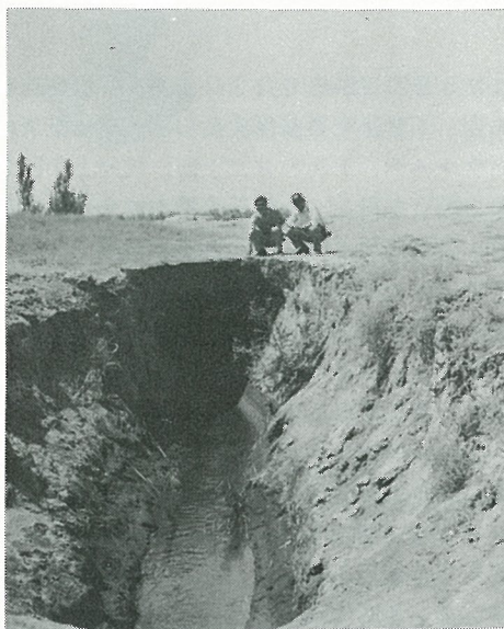
写真1 カレーズ（地下水路）の出口
