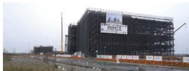
北東から見た建設現場
