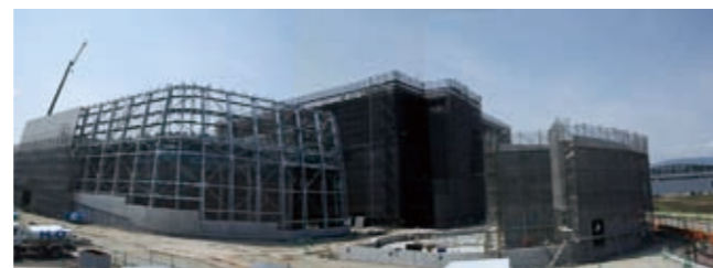
南東から見た建設現場
