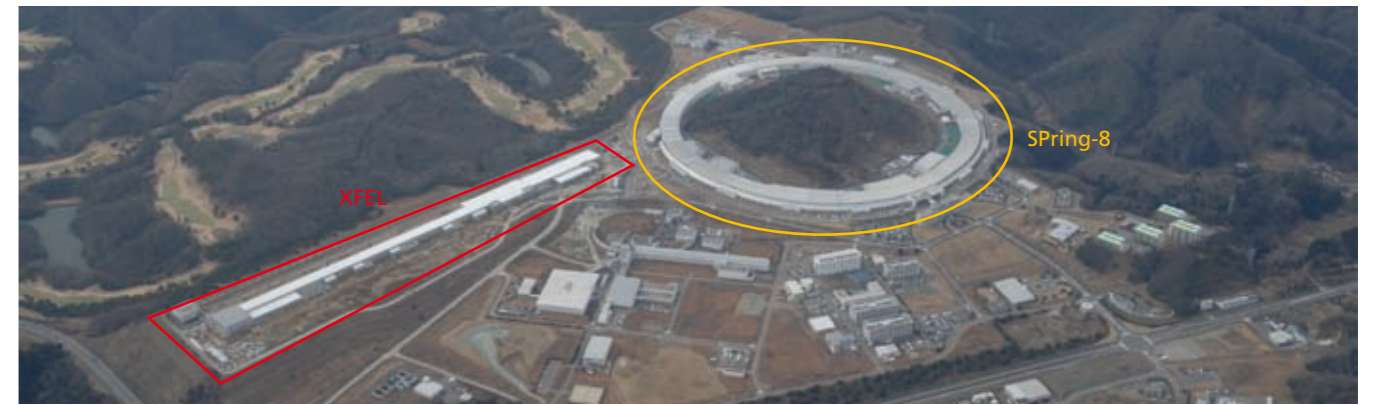
図3 建設中のXFEL施設 兵庫県播磨科学公園都市のSPring-8の隣に建設中。発生するX線は、SPring-8の10億倍もの明るさ（輝度）を誇る。
