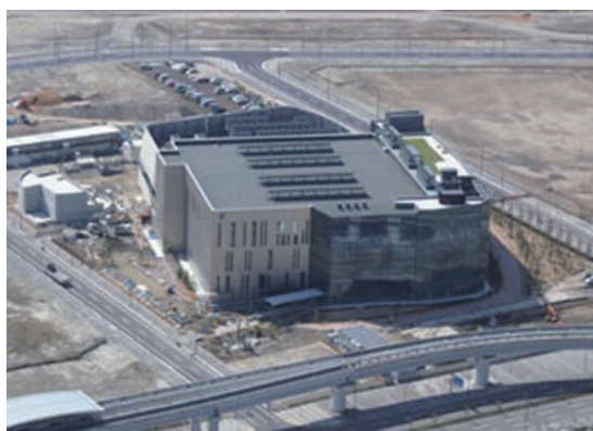
図3 完成間近の次世代スーパーコンピュータ施設 (2010年)
