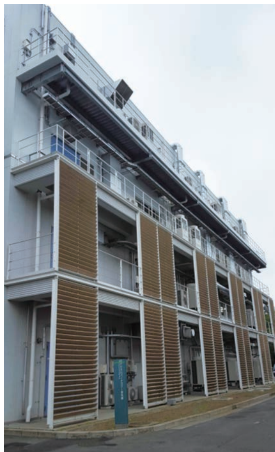
図2 ケミカルバイオロジー研究棟
