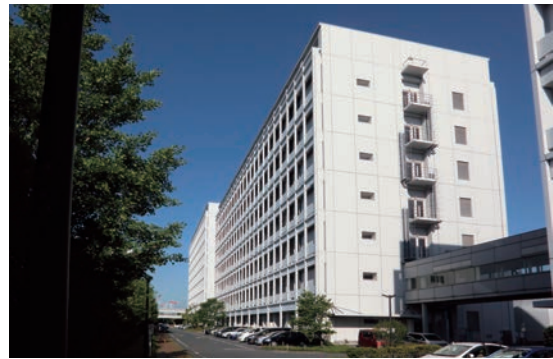
横浜事業所東研究棟（奥）と中央研究棟（手前）
