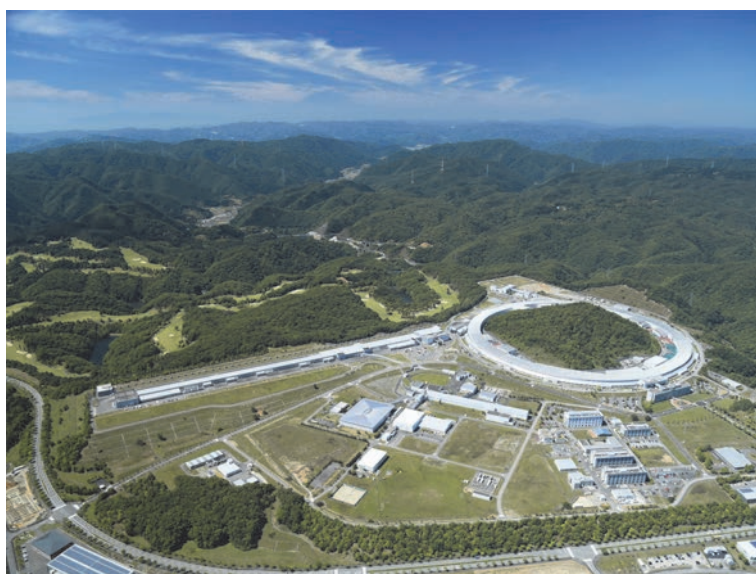
図1 放射光科学総合研究センターの全景 SPring-8蓄積リング棟とSACLA (左の直線部分)
