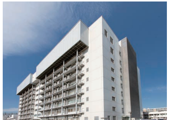
2000年に完成したBSI中央研究棟
