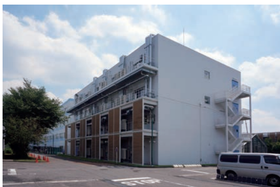
和光事業所ケミカルバイオロジー研究棟
