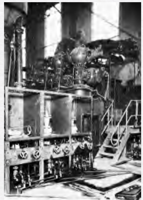
科研式低圧酸素製造装置 大量に酸素を使う製鉄に貢献
