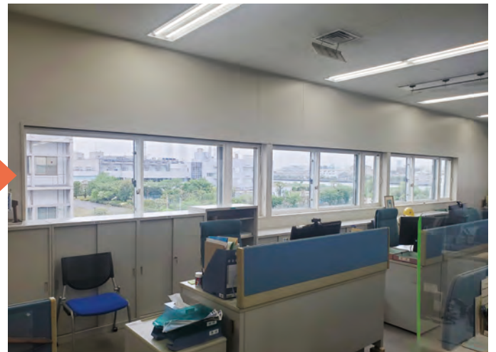
②二重サッシ設置後
