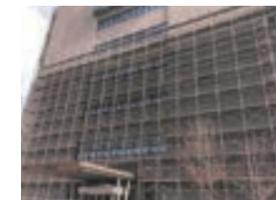
またタイル目地の隙間からの浸水については、その貼り付けてあるタイルの剥離を誘発し、タイル落下による事故の危険性もあります。今回の改修工事では高層階まで足場を組み、直接タイル外壁の打診調査を行って、不良箇所には適切な処置を行いました。
