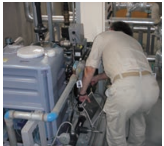
排水設備の日常点検の様子
